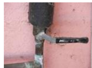
Foto 3 - Una válvula de bola
