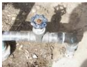
Foto 2 - Una válvula de Puerta
